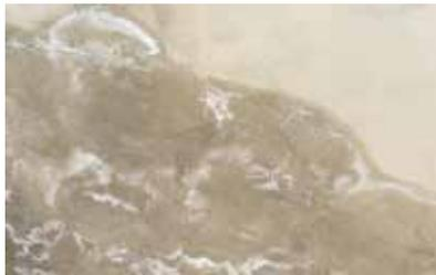
• **Presencia de eflorescencias:** Conviene limpiarlas con agua a presión y aplicar un producto adecuado, como **ANTISALMOR**, ya que éstas pueden disminuir la adherencia de la impermeabilización al ser aplicada. En ocasiones, las eflorescencias indican también la presencia de flujo de agua desde el terreno hacia el interior del vaso, por lo que conviene investigar la presencia de posibles filtraciones y repararlas mediante el uso de morteros específicos para ello, como **MORCEMREST OBTURADOR**
