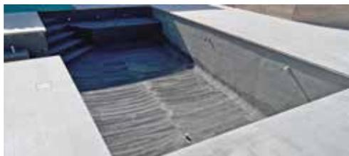
El soporte deberá haber sido tratado previamente con la impermeabilización flexible MarblePool IMPER, Nivel 1. Evitar trabajar sobre soportes calientes, ya que esto puede provocar merma en las propiedades del producto. De ser necesario, refrescar con agua los mismos antes de llevar a cabo la aplicación.
