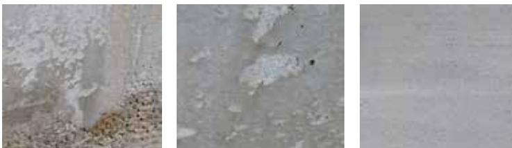
• **Presencia de agentes contaminantes en la superficie:** Examinar la posible existencia de grasas, mohos, pinturas, desencofrantes, etc, ya que pueden afectar a la adherencia del sistema de impermeabilización, por lo que deberán ser eliminados previamente a su puesta en obra.
