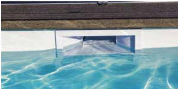
• **REBOSADEROS HORIZONTALES:** El sistema de impermeabilización debe ser continuo desde el vaso y discurrir recubriendo toda la superficie de la canal de desagüe, hasta el encuentro con la playa de la piscina. Entre el vaso desbordante y la canaleta siempre se suelen producir roturas o fisuras, siendo una zona especialmente sensible a patologías, por lo que se recomienda armar la impermeabilización **MARBLEPOOL IMPER Nivel 1**, con la malla recomendada en el Manual de Aplicación.
