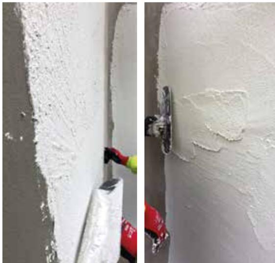
La aplicación se debe realizar con llana de puntas redondas y flexible, y podrá ayudarse de otros utensilios adaptados a medias cañas, esquineros, etc.
