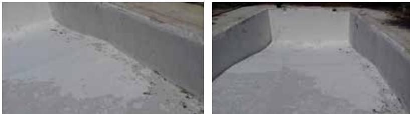
• **Textura de la superficie:** Las texturas superficiales excesivamente rugosas y/o porosas pueden provocar un incremento del consumo del producto impermeabilizante, así como la existencia de poros no impermeabilizados que pueden anular puntualmente los efectos del sistema de impermeabilización ejecutado. Es por ello que la superficie del vaso será lo más lisa posible y con ausencia de poros u oquedades.
